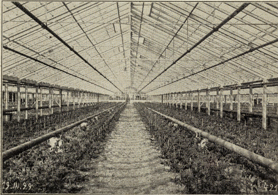
Abb. 2. Blick in die Gewächshausanlage des Großkraftwerkes Klingenberg
